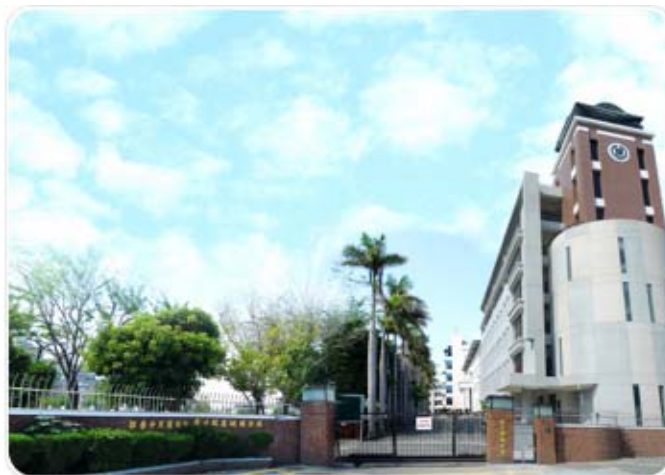
勤學樓國中部教學大樓 & 中華西路側門口
